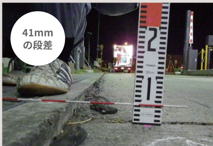
施工前：CO舗装版のみ沈下
