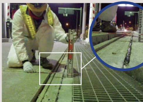
施工後：カッターで縁を切断し、CO舗装版のみ沈下修正
