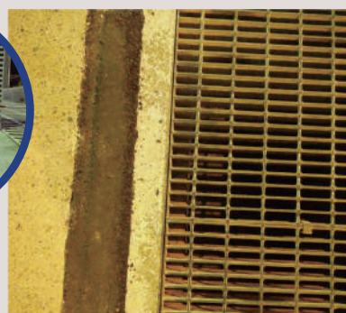
施工後：アスファルト塗りつけ
