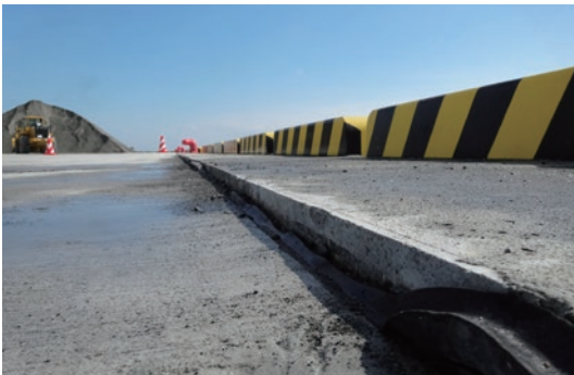
地盤沈下によって水勾配が取れなくなり水溜りが出来た港湾荷降ろし岸壁
