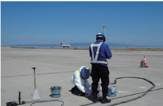
空港の段差修正
