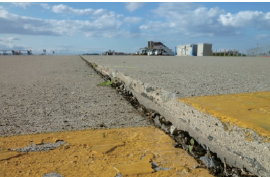
空港エプロンに出来た段差修正
