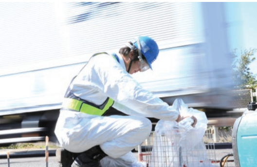
供用を止めない高速道路の空洞充填工事
