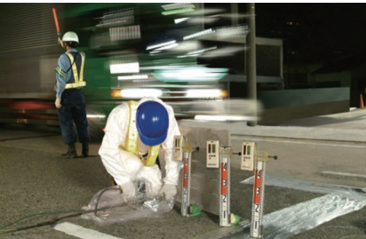
供用を停止せず施工が可能
