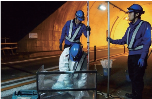
コンクリート舗装版下の空隙・空洞充填
