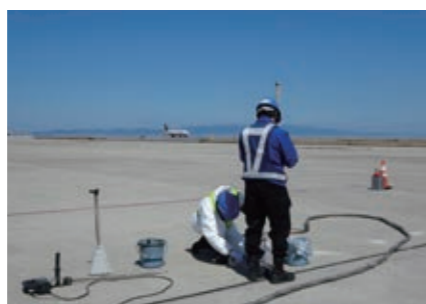
空港の段差修正
