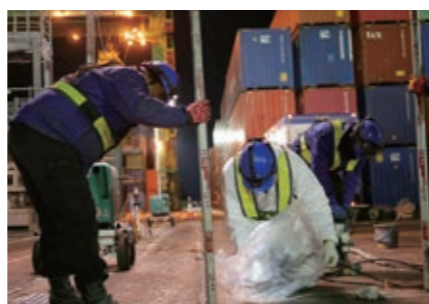
RTG走行路版の不陸や沈下・段差修正
