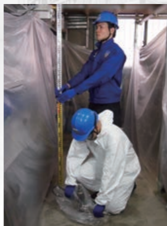
ミリ単位で床レベルを制御しながら沈下修正をおこなう
