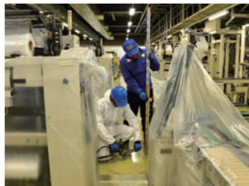
機械など、移動せずに施工が可能
