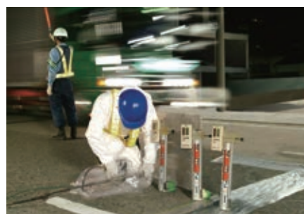
供用を停止せず施工が可能
