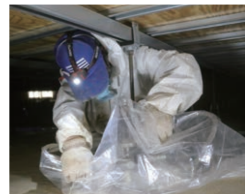
ステージ下でのウレタン樹脂注入
