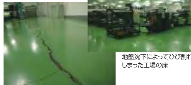
地盤沈下によってひび割れてしまった工場の床
