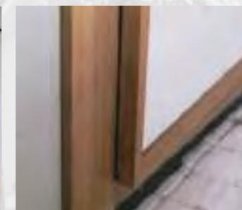
沈下により枠が歪み扉が閉まらない
