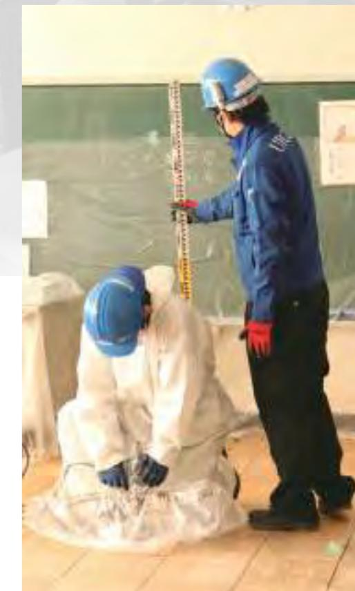
たわんだ床の沈下修正は一般的な教室の広さなら1日で施工が可能
