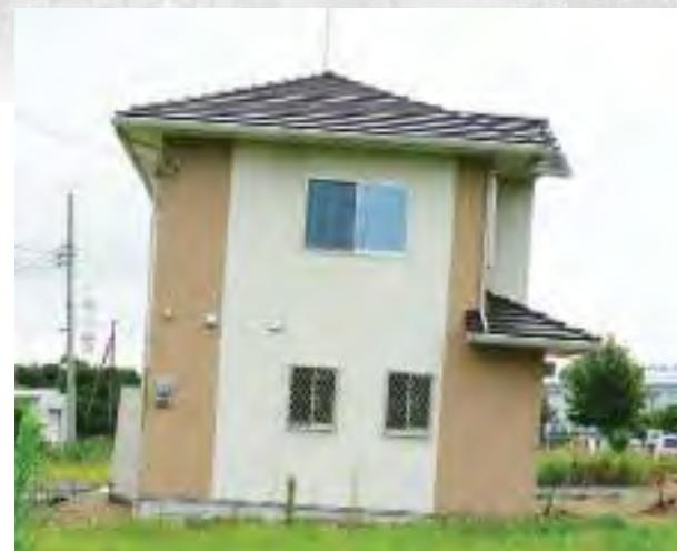
地震による液状化のため大きく沈下してしまった住宅
