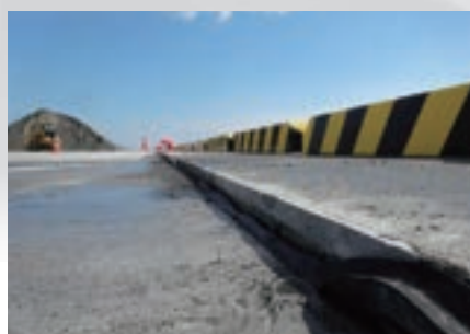
地盤沈下によって水勾配が取れなくなり水溜りが出来た港湾荷降ろし岸壁
